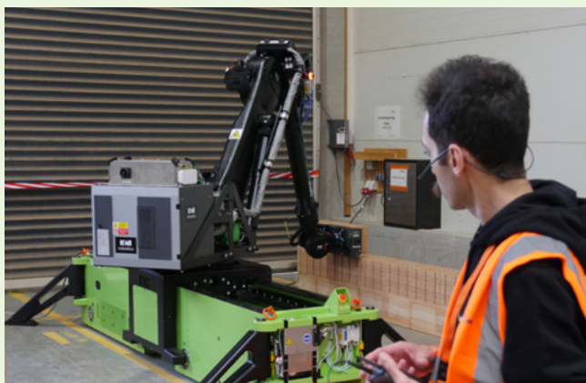
Mauerwerksroboter WLTR zum ersten Mal in Aktion in Deutschland
